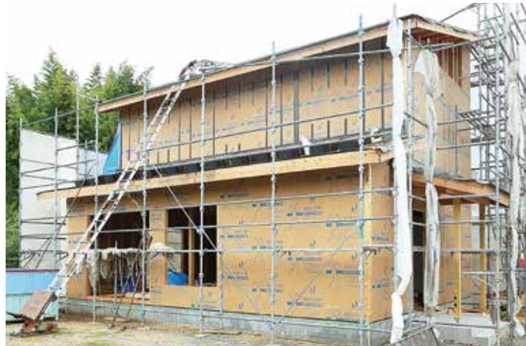
筋交い+耐力壁のW耐震の構造
