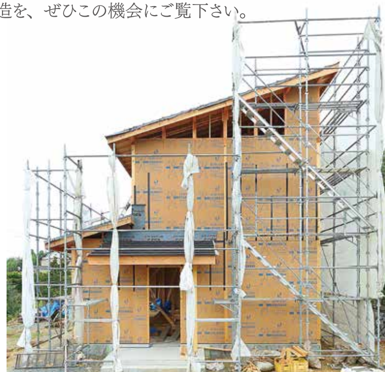
筋交い+耐力壁のW耐震の構造
